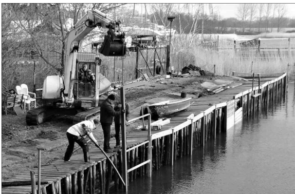
Arbeiten bei niedrigem Wasserstand
