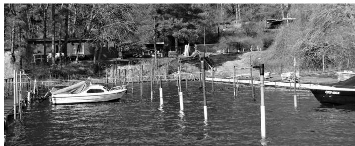
Die sanierte Kaikante als helle Linie rechts im Bild.. Fotos: K.Petersen
