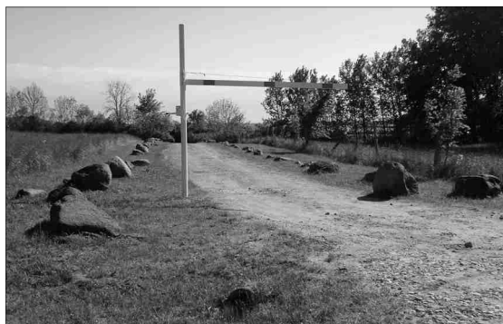
Inzwischen wurden die Steine so verlegt, dass ein Umfahren der Schranke nicht mehr möglich ist.
